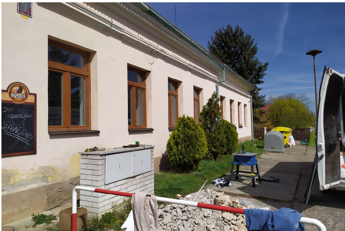
Fotografie z probíhajících prací na rekonstrukci oken a parapetů z vnějšku budovy.
